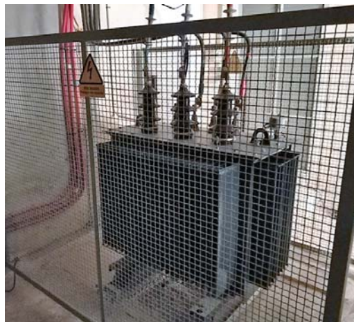
Imagen 17. Transformador eléctrico
