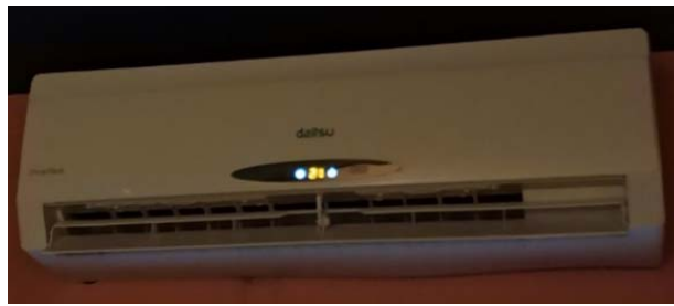
Imagen 12 Equipo Salas Torres del Port
