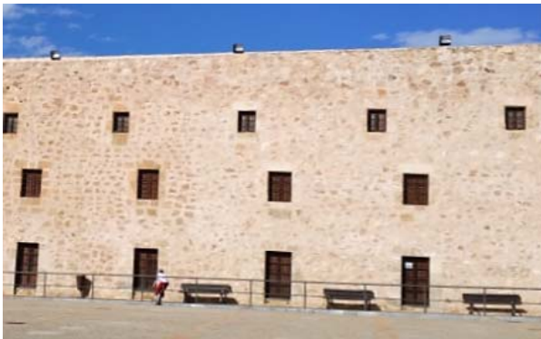
Imagen 7. Ventanas del centro cerradas
